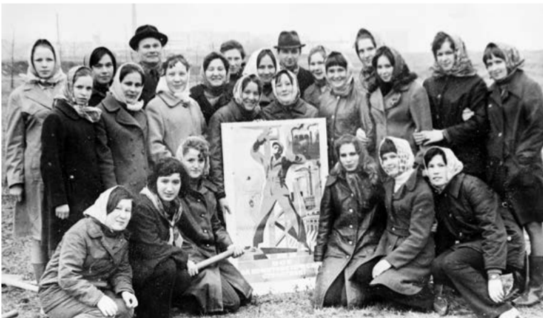
Классный руководитель Нил Морозов со студентами на строительстве пристроя к техникуму. 1978 год. Фото из личного архива.
